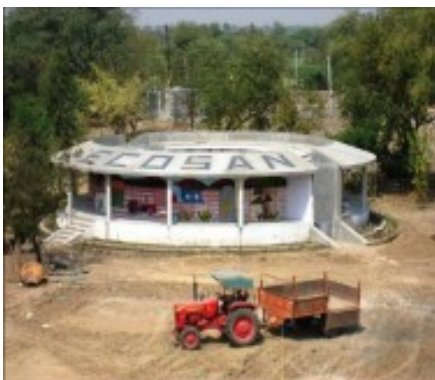
Foto: GTZ Ein ecosan-System-Toilettenblock in Indien
