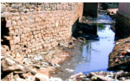
Foto: GTZ Offener Abwasserkanal mit Schwarzwasser
