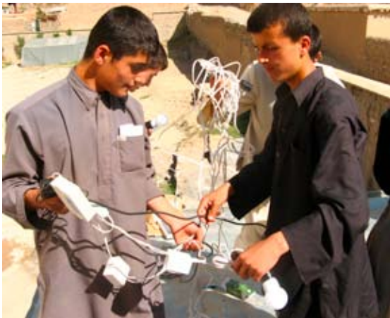
Studenten lernen die Installation eines kleinen Solarsystems für den Hausgebrauch. (F: DED)
